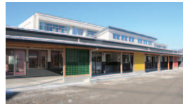
田中小学童クラブ棟竣工検査
