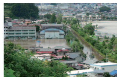
当時の被害状況(南部中付近)
