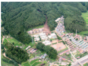
上の原小裏の土砂崩落
