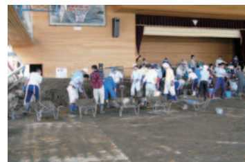
体育館の泥の撤去作業
