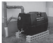
雨水貯留タンク
