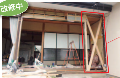
サッシを撤去し、筋交いを取り付けて補強
