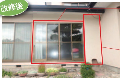
筋交い部分は壁を新設し、サッシを交換して、補強工事の完了
