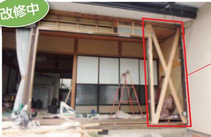
サッシを撤去し、筋交いを取り付けて補強
