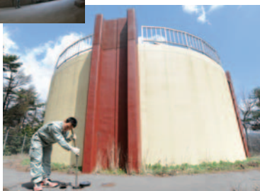
樋沢配水池での見回り
