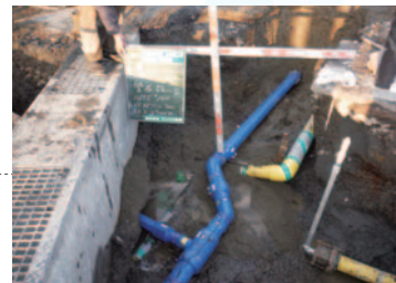
断水にしない、水をむだにしない、など細やかな配慮で施工
