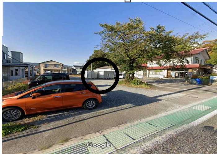
仮設屋外スピーカー（柱含む）【高さ:約14m】設置予定地 西堀区公所駐車場・防災倉庫横
