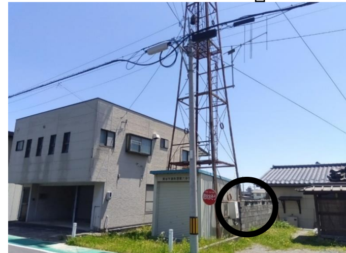
新設屋外スピーカー（柱含む）【高さ:約15m】設置予定地（火の見やぐら裏） 消防団第6分団火の見やぐら裏 ※火の見やぐらは撤去し、倉庫は建て替えます
