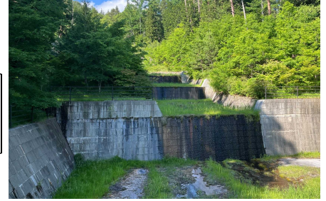
災害後造成された砂防堰堤の一つ 「上の原砂防堰堤」の現在 写真：2024年 市史編さん室撮影
