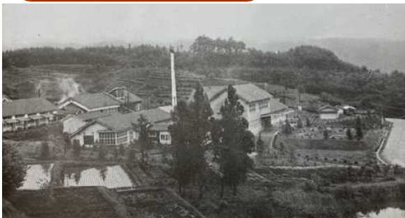
開院当時(右側建物が本館) 撮影年不詳
