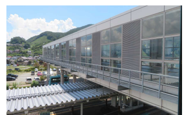
↑ 線路をまたぐ駅南北自由通路
