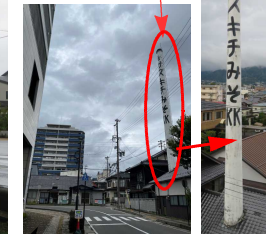
現在の立体駐車場と煙突
