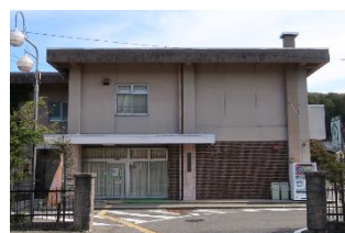
岡谷市川岸公民館
