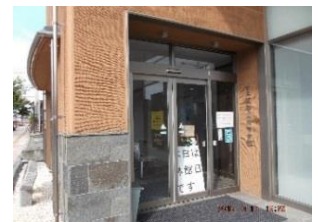
現在の入口（風除室）
