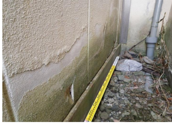
PM-2 南校舎玄関の外壁の剥離性亀裂。
