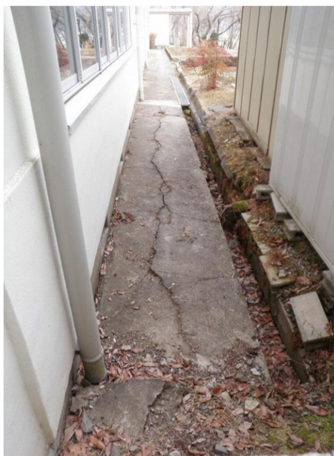
PKt-4 管理教室棟側の犬走りは、沈下による破損が著しい。
