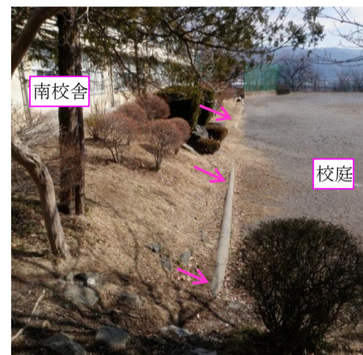
PG-1 南校舎の校庭側では、盛土が変形している。
