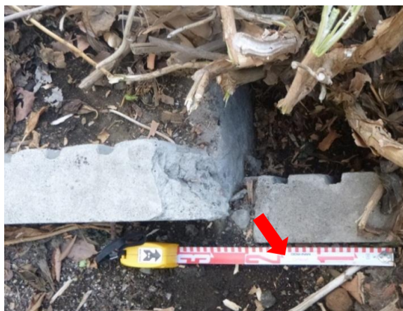
PK-4 管理教室棟の北側の側部における花壇ブロックの破断。
