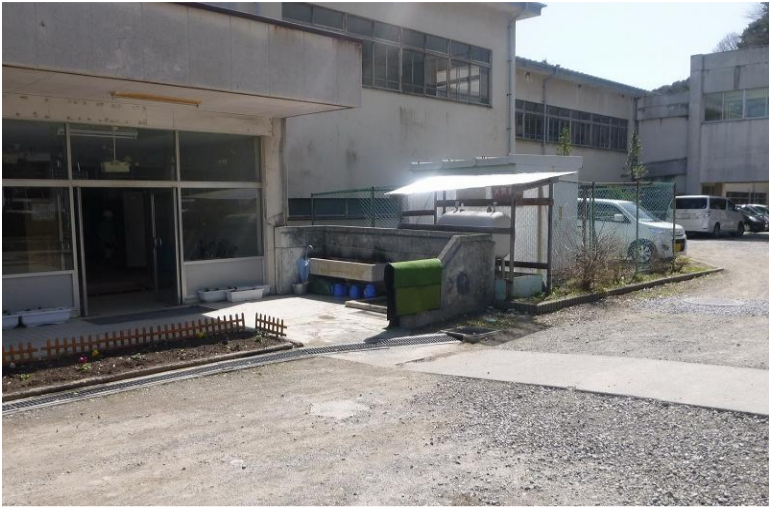
PM-1 南校舎の玄関付近は地表沈下が著しい。
