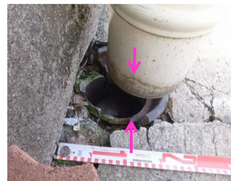
PKt-3 犬走りの雨水管の受け口は地盤変状により位置がずれるとともに、山谷方向の圧縮により押しつぶされている。
