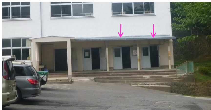
PKt-1 北校舎の玄関は沈下により屋根が傾いている。
