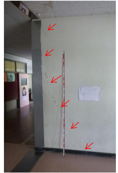
PM-6 南校舎の中央部北側の亀裂。
