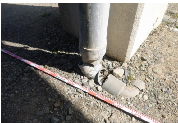
PK-5 地盤沈下と側方変位により雨水管が変形する。
