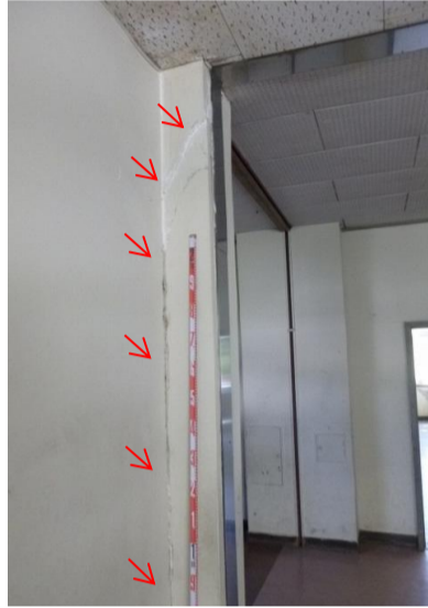
PM-5 南校舎の中央部北側の亀裂。
