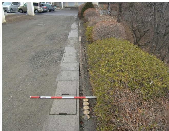
PMr-1 南校舎～管理等教室付近の法肩に開口亀裂が連続する。
