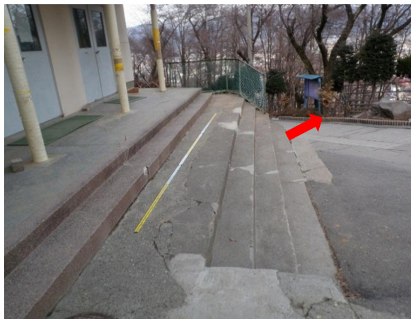
PKt-2 北校舎玄関の付近は破損が著しい。沈下とともに、谷側への水平変位も認められる。
