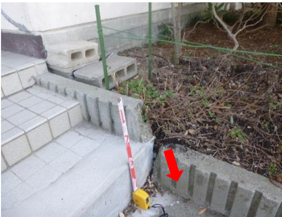
PK-3 管理教室棟の玄関における花壇ブロックの破断。
