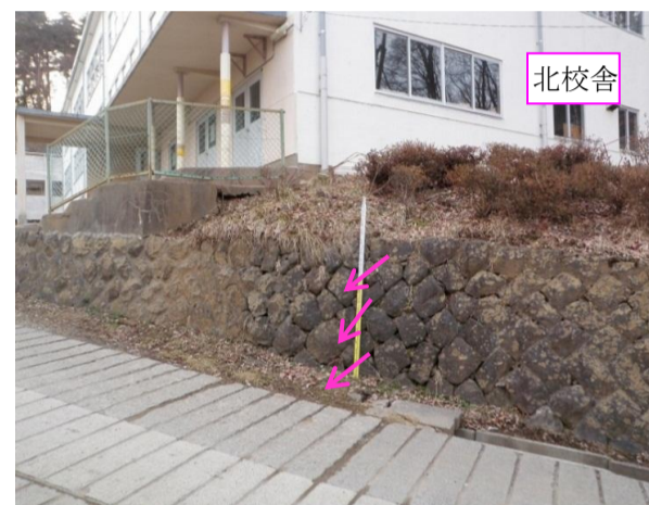
PKt-6 北校舎の玄関付近の通学路沿いに、空石積みのはらみ出しあり。
