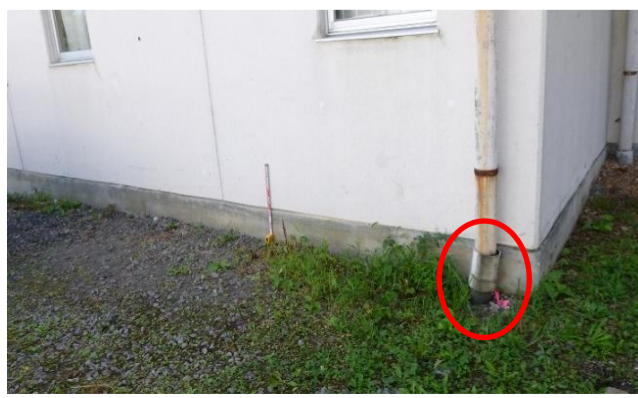
PK-6 地盤沈下と側方変位により雨水管が変形する。
