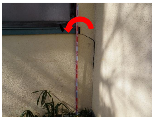
PP-1 プール付属施設は損傷が激しい。沈下による前傾亀裂が多い。
