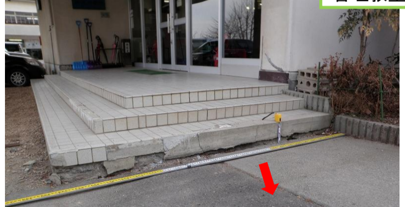
PK-2 管理教室棟の玄関における沈下。基礎と地盤の間に空洞が生じている。(その後、基礎の表面を修復)
