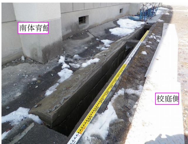
PMt-1 南体育館の校庭側では、地盤沈下による変状あり。水路の浮き上がりは、凍上による。
