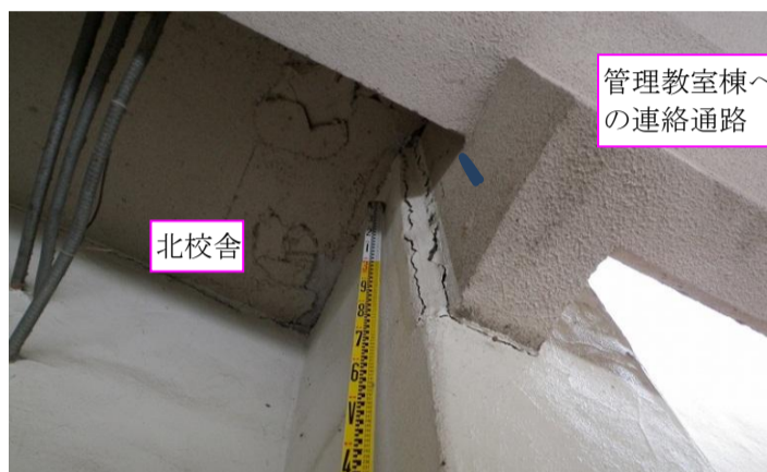
PKt-5 管理教室棟と北校舎連絡通路は、ねじりによる回転運動で破断する。
