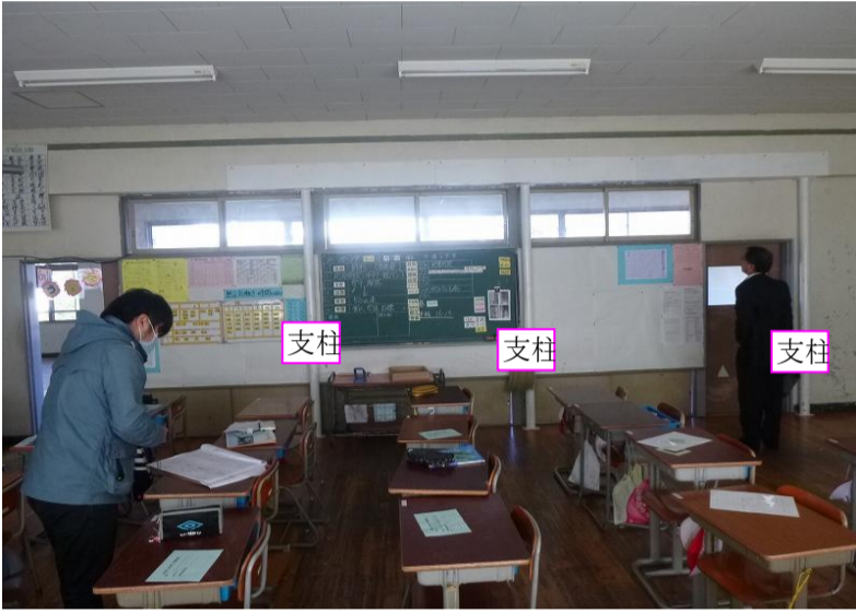
PM-4 南校舎の東側では、梁がたわんだため鋼製の支柱で支えている。
