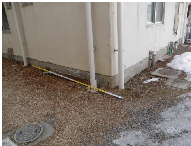
PKy-1 給食室棟周辺では、地盤沈下のために配管が抜け上がる。
