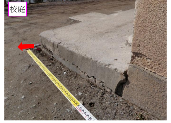
PM-3 南校舎の南側は校庭方向に変位する。
