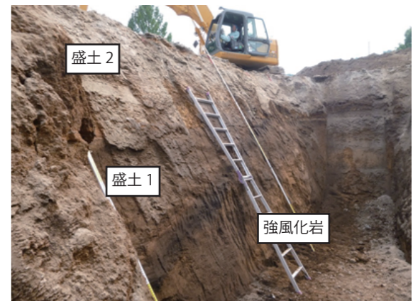
トレンチ内の状況。
