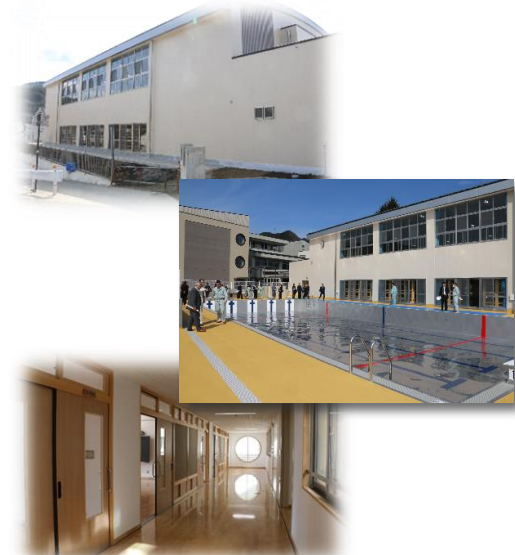
【岡谷西部中学校改築工事】
