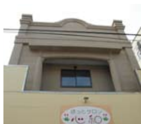
中央通りの看板建築
