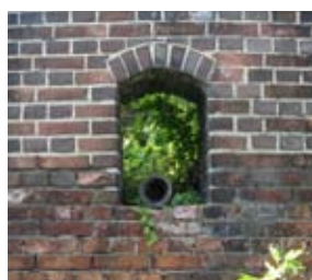
レンガ積み (丸山タンク)
