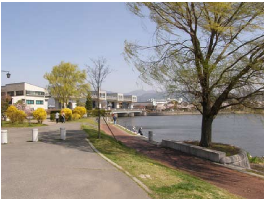
現在の釜口水門 [22]
