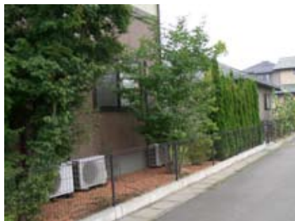
エアコンの屋外機を植栽で隠す。
