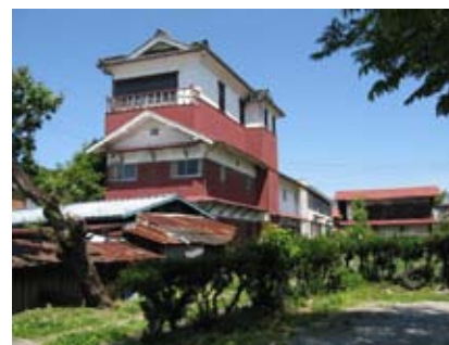
湖畔沿いにある製糸時代の建物
