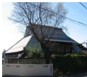
茅葺き屋根を金属板で葺き替えた屋根
