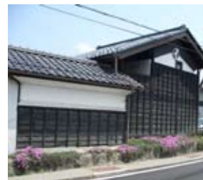
腰板壁の土蔵
