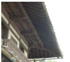
せがい造り 軒の下に天井が張られている
