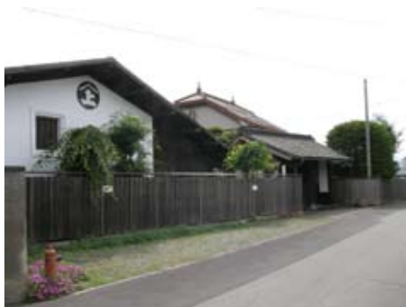
旧山上宮坂製糸事務所・住宅（加茂町）[7]
