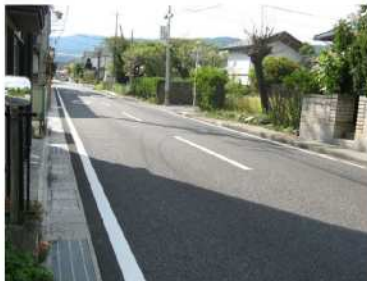
道路32号線(1)整備
