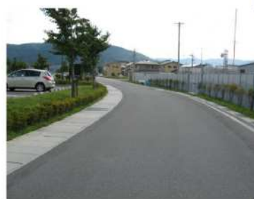
道路岡谷41号線(1)整備
