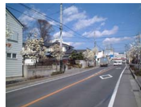
歩道、街路樹の整備が進む下諏訪辰野線
