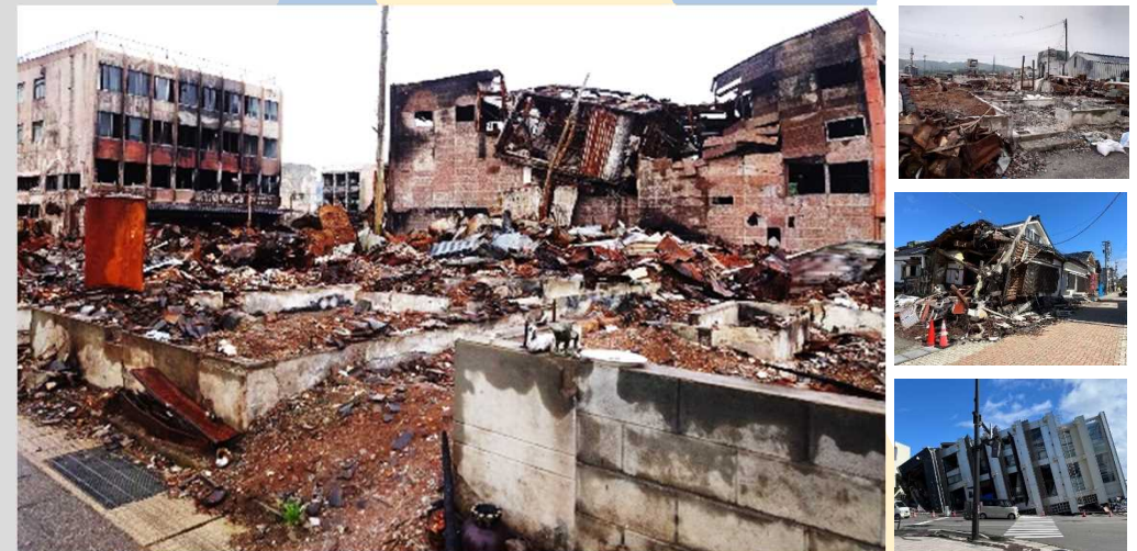
令和6（2024）年能登半島地震による被害
