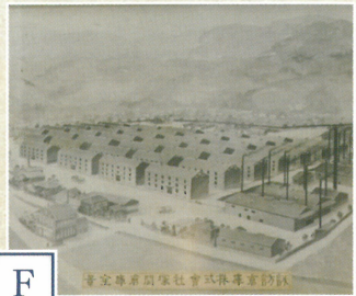
F 諏訪倉庫の塚間倉庫群(明治42年創立、昭和56年まで経営)。
