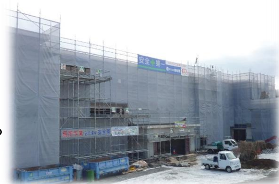
【改修工事が進む岡谷東部中学校管理教室棟】
