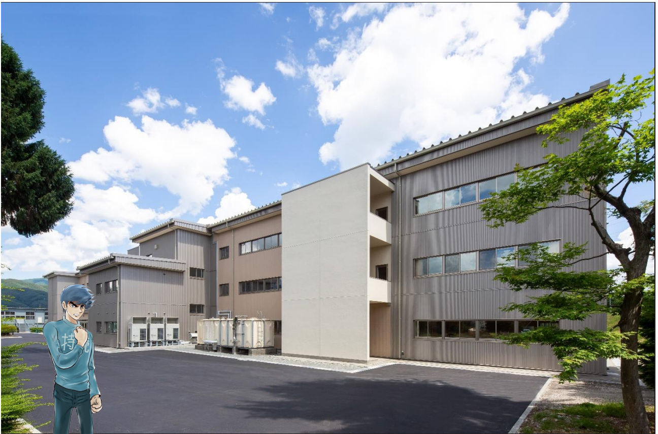
岡谷東部中学校管理教室棟大規模改修工事（令和3年度竣工）
