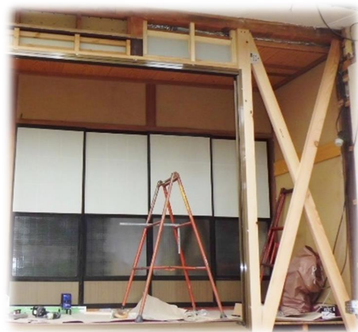
耐震改修の様子
