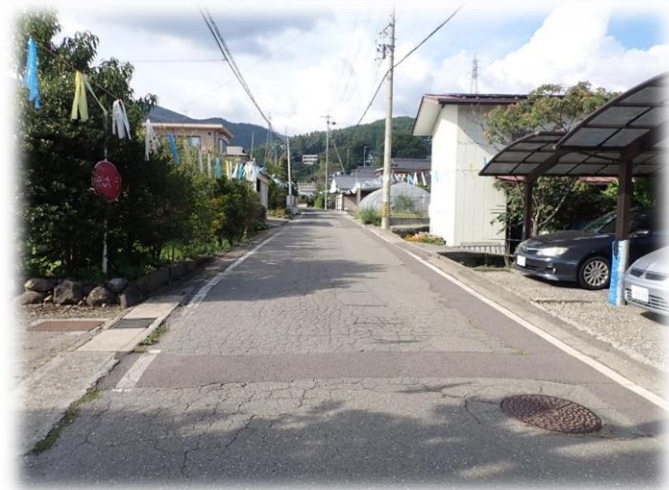
維持補修工事を行う市道22号線（横川東堀線）
