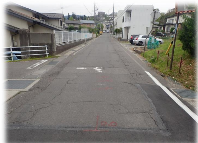
維持補修工事を行う市道4号線（間下道線）
