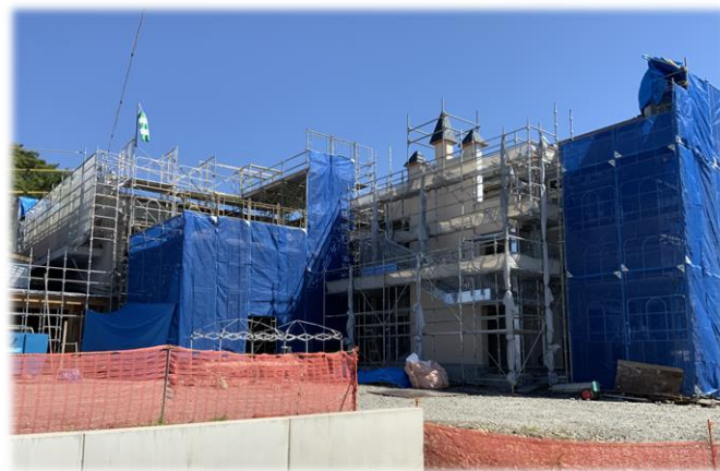
【建設中の新西堀保育園】
