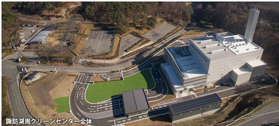
諏訪湖周クリーンセンター全体
