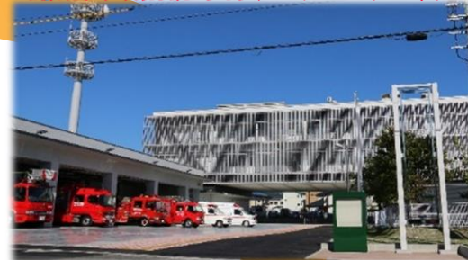
諏訪広域消防本部 岡谷消防署
