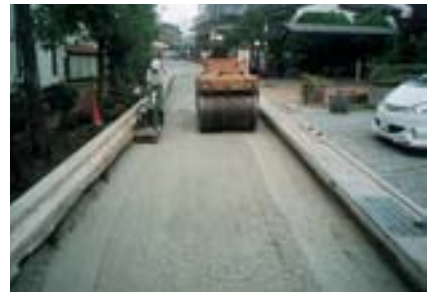
生活道路の整備
