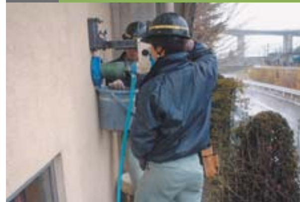
●耐震診断・改修など災害に強いまちづくり
