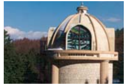
内山水源配水池
