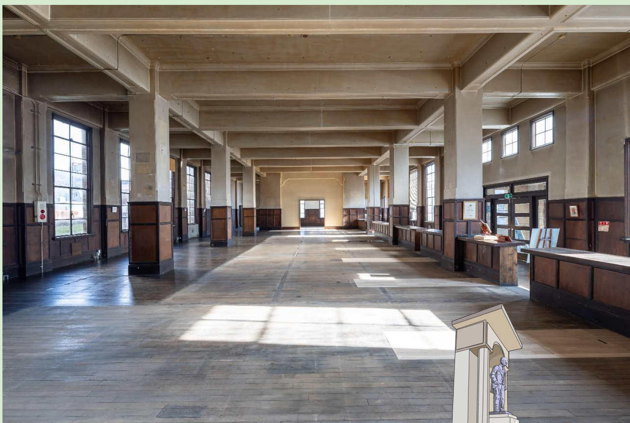
旧岡谷市役所庁舎耐震工事
