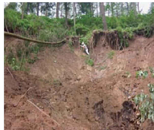
写真 1-2 崩壊地滑落崖と樹木根系の状況
