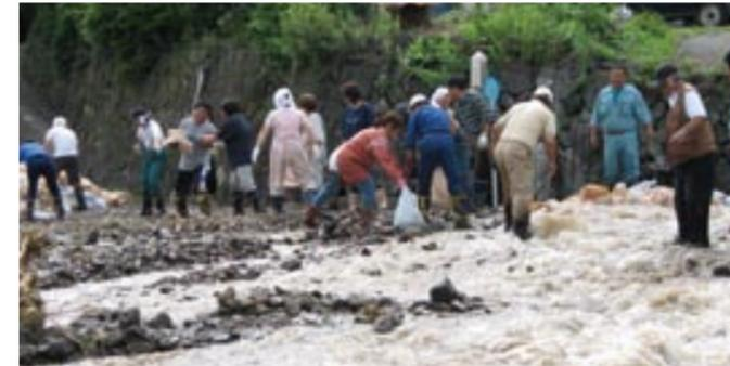
川岸新倉区にある普通河川大洞沢川が異常出水したため、上流部で石積護岸が破損し河床が洗掘された。そのため上流部から流れ出た土砂が下流部の狭い暗渠区間で閉塞溢水し、住宅などに大きな被害が発生した。
