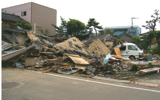
写真は2007年7月に発生した「中越沖地震」の状況です。(写真提供:消防庁)
