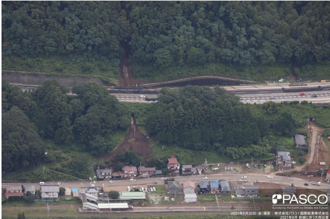
図 令和3年8月大雨時の被災状況（川岸鮎沢区 中大久保）
