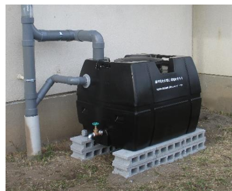
（雨水貯留タンク）
